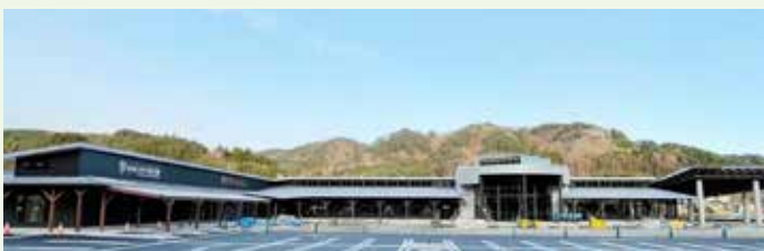
外観(久慈市HPより)
